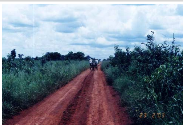
FIGURA 1. Estrada interna do PA Tiro e Queda.
